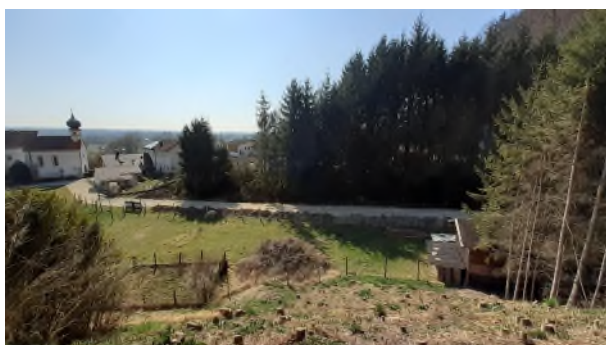
Abb. 1: Beschriftung Die Arbeiten zum Hochwasserschutz im Winhöringer Ortsteil Burg beginnen an der unteren Sperre im Bürgerbach. Eine Zufahrtsstraße zur Baustelle ist bereits angelegt. Foto: Wasserwirtschaftsamt Traunstein
