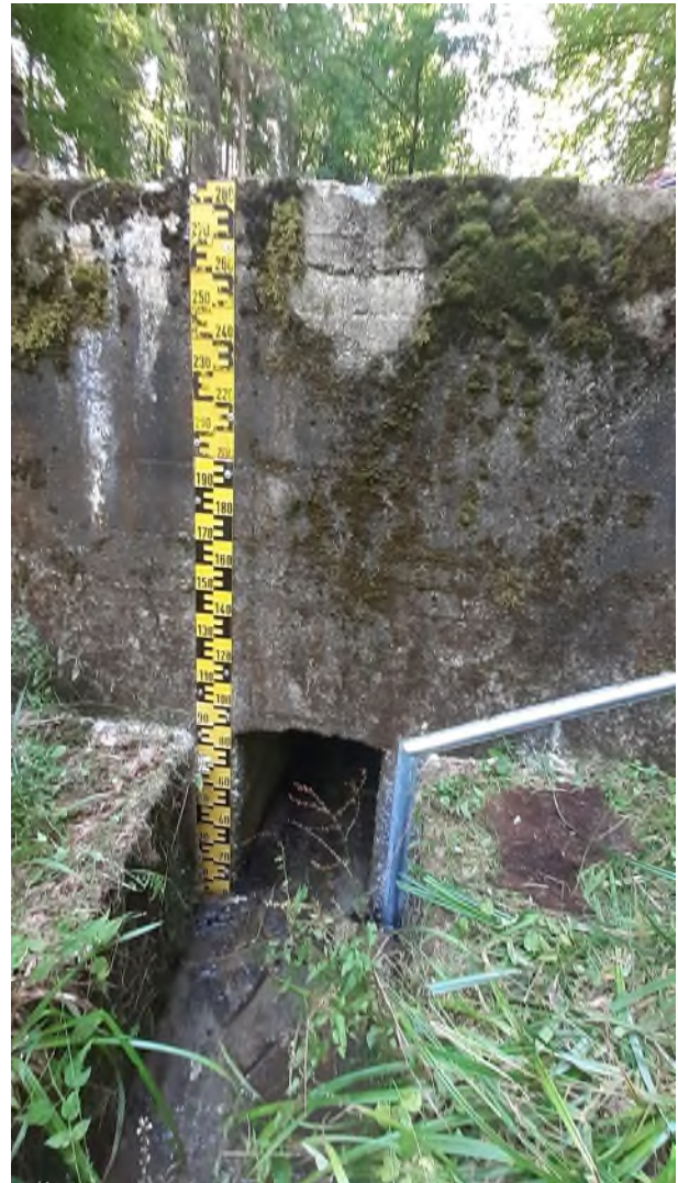
Abb. 4: Durch diese kleine Öffnung in der Mauer, den Grundablass, kann das Wasser im Regelfall abfließen. Steigt es zu hoch, meldet der Hochwasserwarnpegel Gefahr. Foto: Wasserwirtschaftsamt Traunstein
